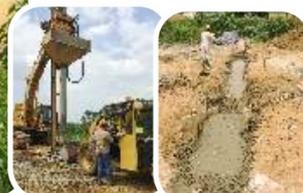
Se adelantan satisfactoriamente las obras de reforzamiento y reconstrucción del jarillón de la margen izquierda del Canal Interceptor Sur. A 31 de julio, ya se han intervenido con procesos de excavación y retiro de material inadecuado, 4.880 metros lineales del dique.
